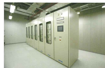
制御盤等搬入・据付工事
