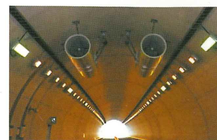
ジェットファン据付・配線工事
