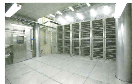
電気集塵機設備工事
