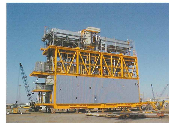
天然ガス圧送モジュール電気計装工事
