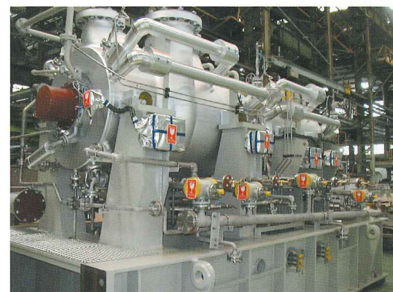
各種ユニット電気計装工事
