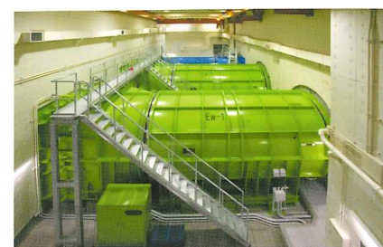
換気設備電気工事
